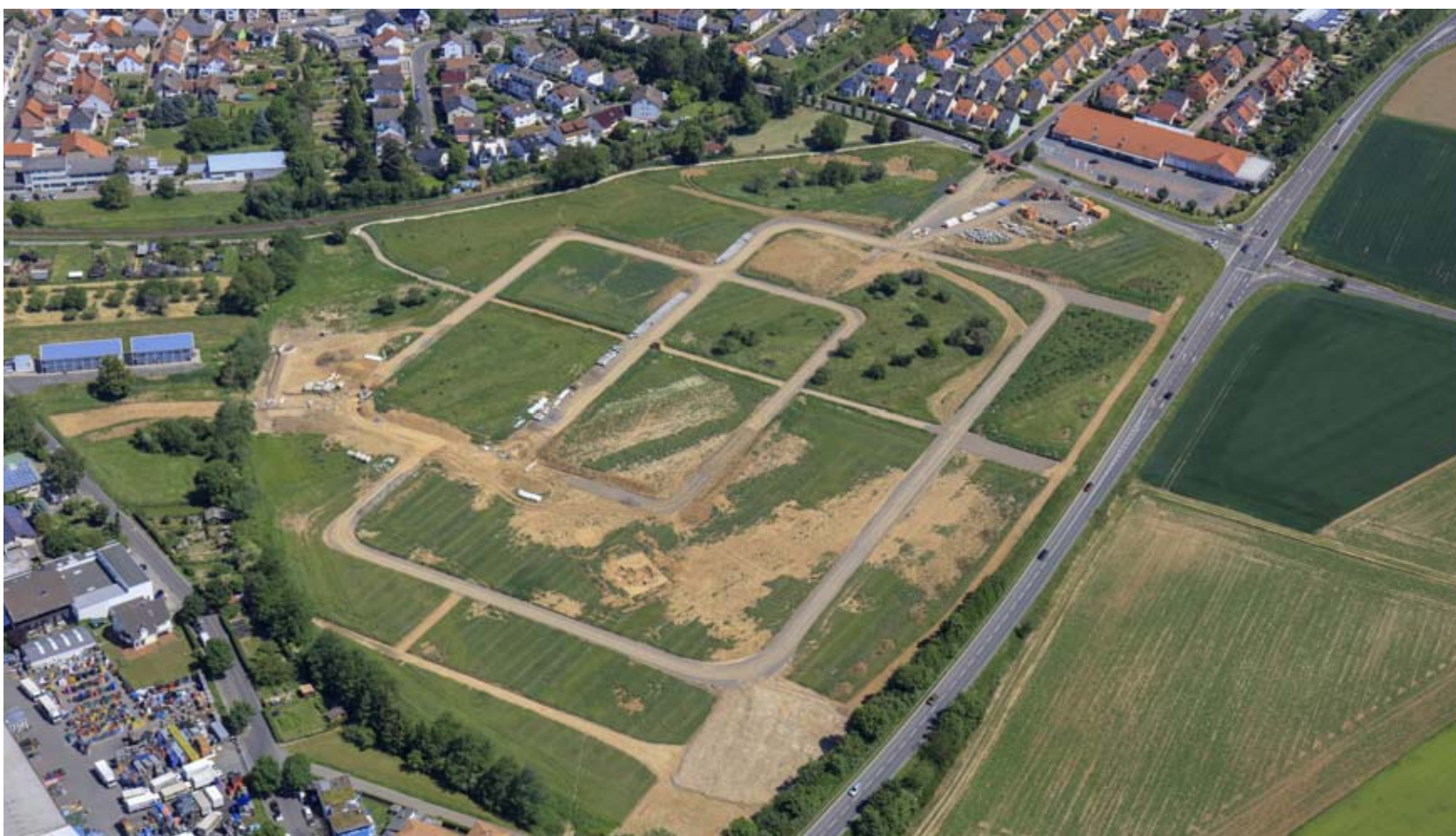
Nimmt Formen an: Die Arbeiten im Baugebiet Im Bachgange schreiten gut voran. Demnächst soll der Straßenbau beginnen.
